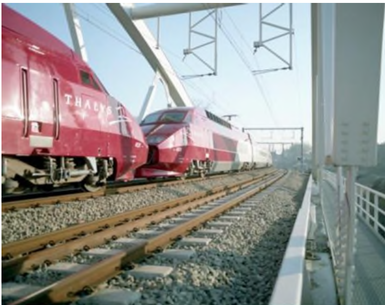
Twee PBA-stellen gekoppeld op het spoorviaduct over het kanaal Brussel-Charleroi in Halle. 1997 (Ref. K01919)
