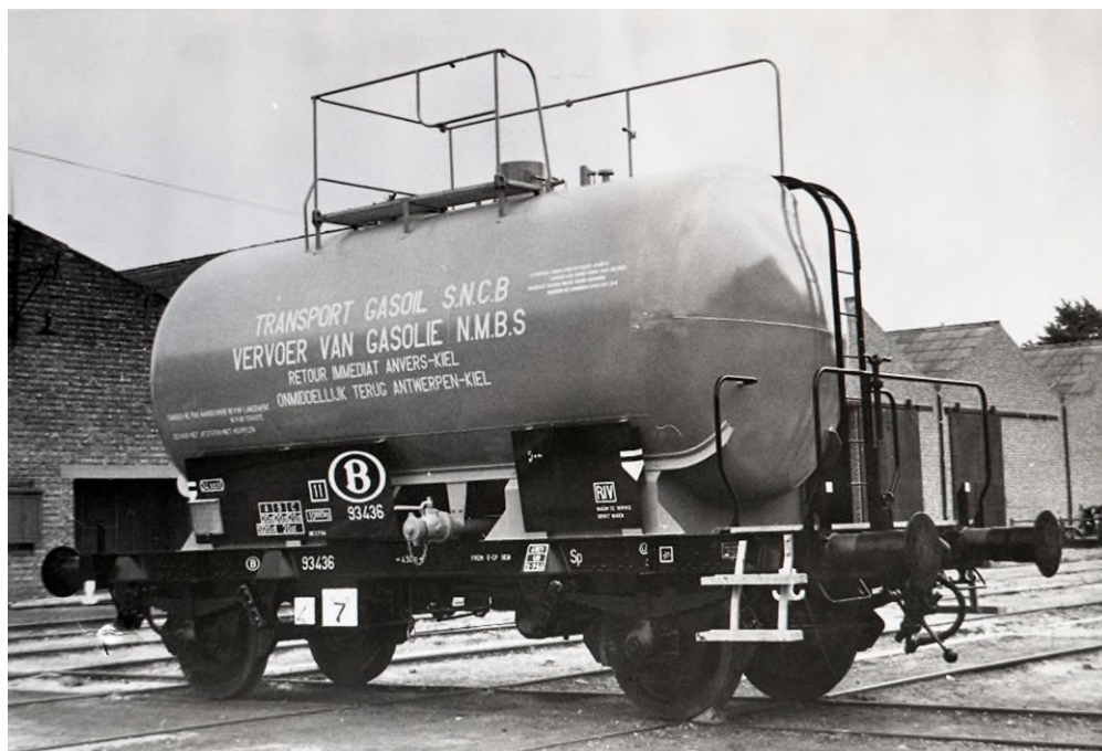
wagons-citernes à 2 essieux, fournis à l'état neuf par Ragheno en 1964 (Réf. Z04131a)
