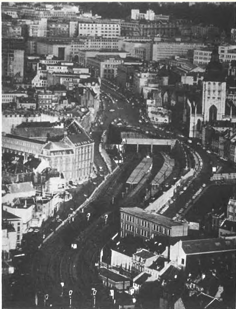
Fig. 6. — Le Chemin de fer urbain. Entrée du tunnel de la Jonction Nord - Midi côté Bruxelles-Midi.
