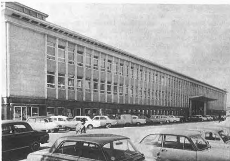
Fig 10. — Nouvelle gare de Hasselt.
