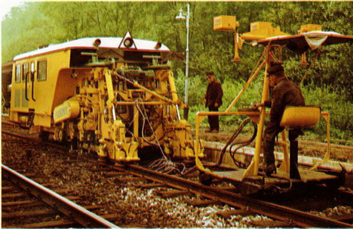
Mécanisation des travaux de voie.
