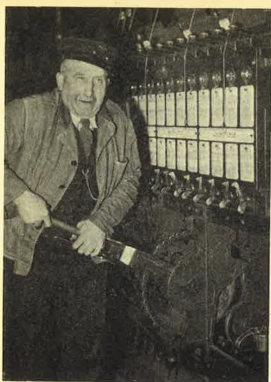
Seinhuiswachter in actie aan een mechanisch bloктоestel.
