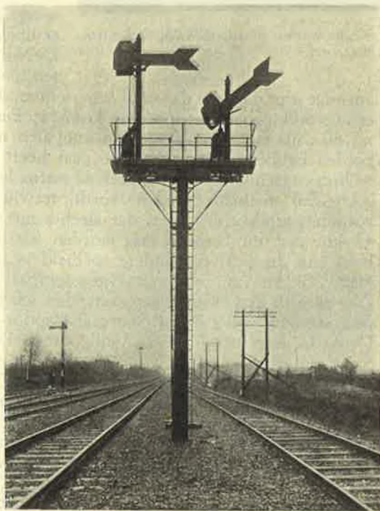
Vertakkingsseinbeeld. Veilig voor aftakkend spoor.
