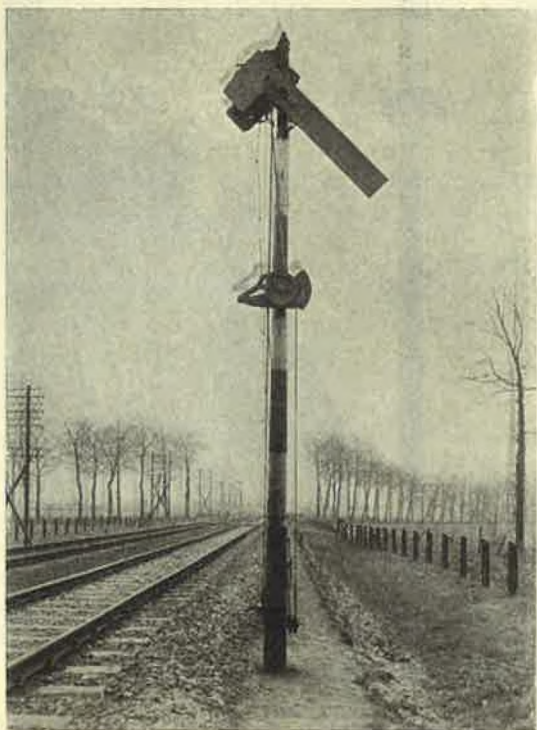
Voorseinpaal. De omlaagwijzende arm geeft aan, dat de daarbijbehorende hoofdseinpaal op on- veilig staat. De machinist moet dus al langzamer gaan rijden.
