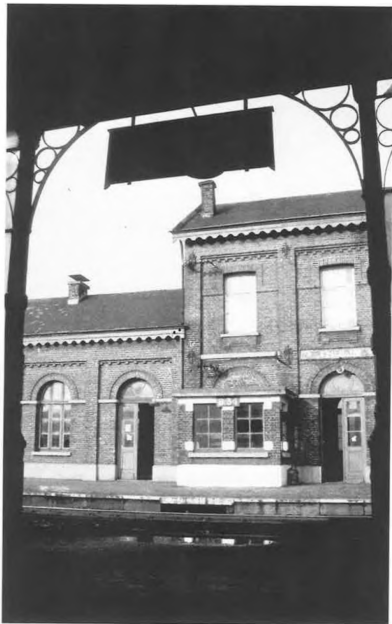
le poste de block 31 de Thulin, sacrifié par l'électrification (photo M. Van Ussel - 20.11.84)
