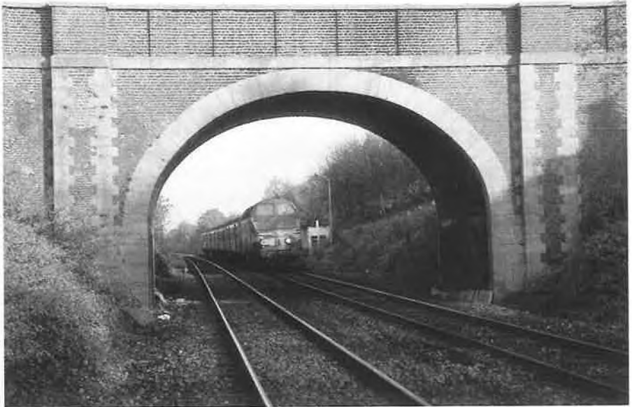
Le passage supérieur de Hainin a dû être démolé pour dégager le gabarit électrique (photo M. Van Ussel - 20.11.84)
