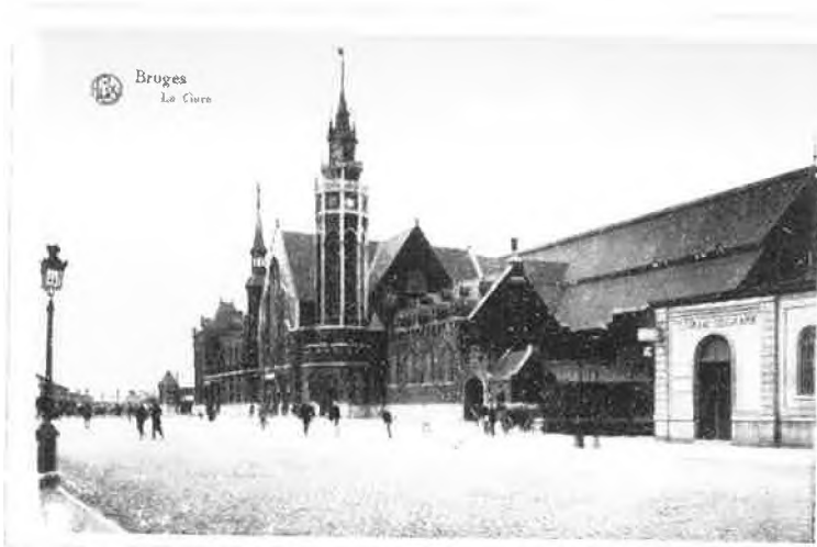
Het voormalige station van Brugge.
