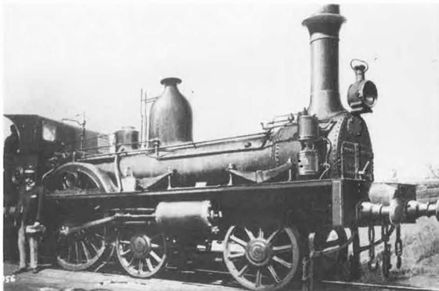
1.- Long boiler n° 2, abri baquet, frein Westinghouse, chaudière et couvre-roues Tubize (LPC 7756).
