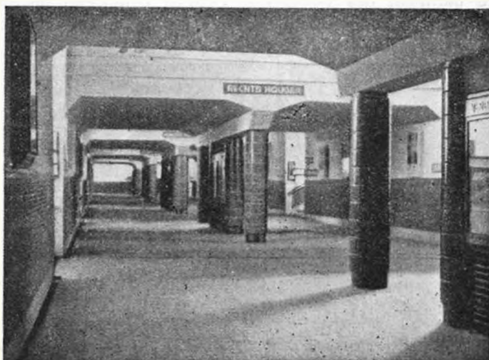
Couloir sous voies.
