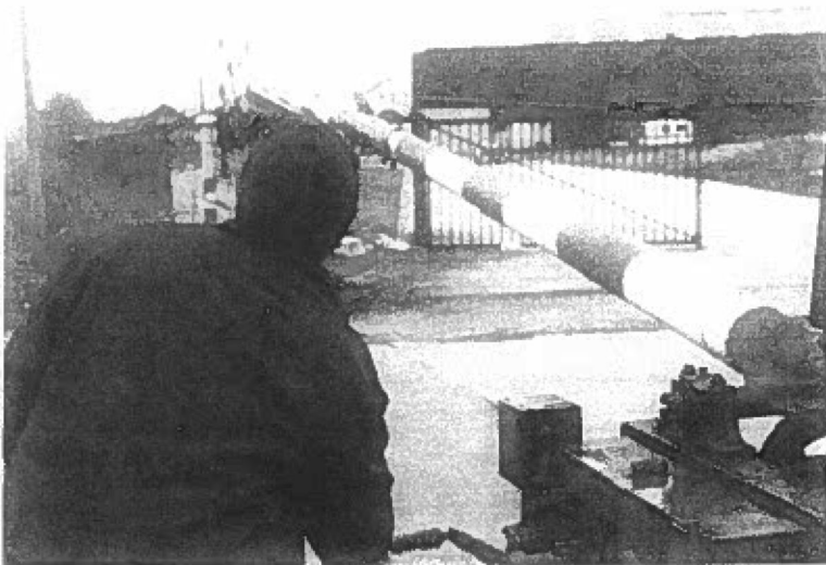
Monsieur Dereau et la barrière bientôt automatisée
