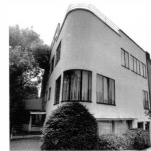
C'est en 1934 que l'architecte Huib Hoste créa pour un confrère cette maison moderniste qui s'inspirait des préceptes mis à l'honneur par Le Corbusier et le mouvement du Bauhaus. Sorte de vaisseau ancré au bord du parc de Woluwe, cette demeure tira un parti étonnant de la déclivité du terrain (n° 333).
