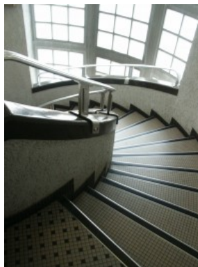
Avenue Fonsny 47, bâtiment administratif, escalier hélicoïdal (photo 2004).
