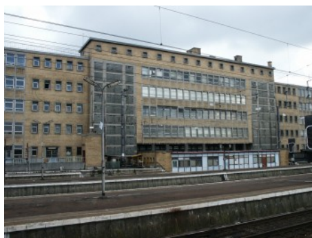
Avenue Fonsny 49, bâtiment administratif, détail des étages (photo 2004).
