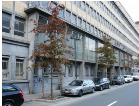
Avenue Fonsny 49, bâtiment administratif, dispositif d'entrée (photo 2004).
