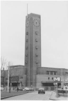
Rue de France, Gare du Midi, porche d'entrée de la gare et tour-horloge, démolis (archives DMS, s.d.).
