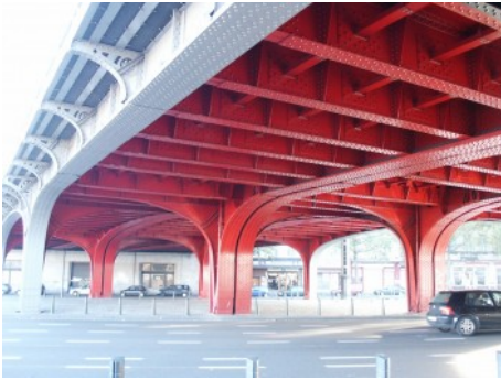
Viaduc du Midi (photo 2004).
