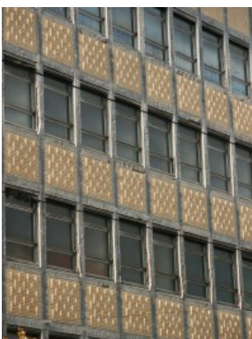
Avenue Fonsny 49, bâtiment administratif, détail des étages (photo 2004).
