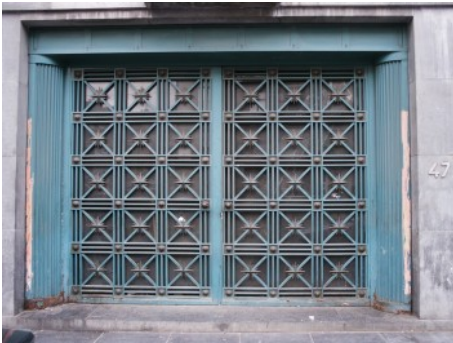
Avenue Fonsny 47, bâtiment administratif, porte en fer forgé (photo 2004).
