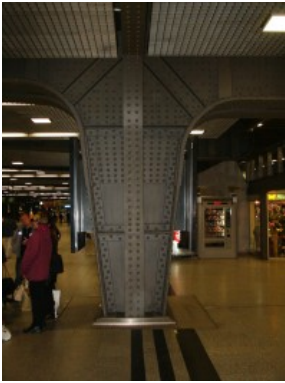
Avenue Fonsny, Gare du Midi, couloir d'accès aux quais, pilier métallique (photo 2004).
