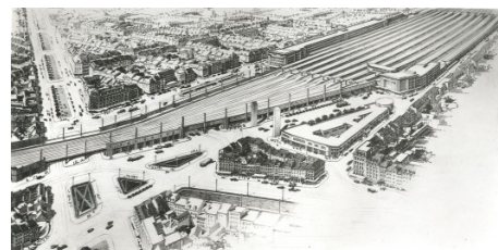
Avenue Fonsny, vue aérienne de la Gare du Midi, dessin des arch. Blomme (IRPA: 60543B).
