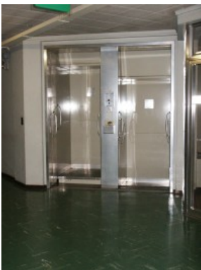
Avenue Fonsny 47, bâtiment administratif, ascenseur de type Paternoster (photo 2004).
