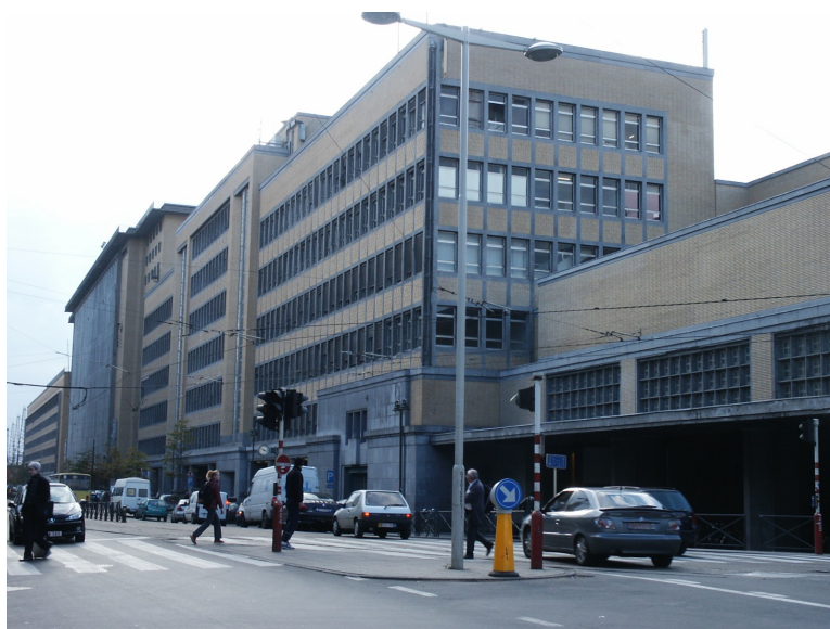
Avenue Fonsny 49, 48, 47, Gare du Midi, porche d'accès à la gare et bâtiments administratifs (photo 2004).
