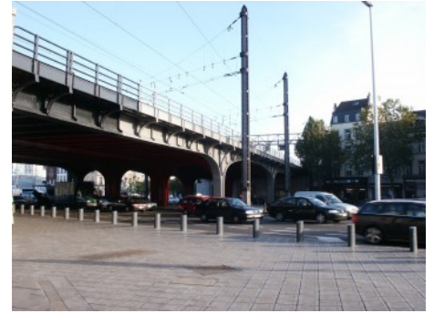
Viaduc du Midi (photo 2004).
