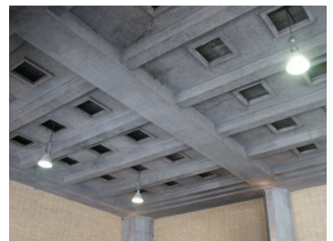
Avenue Fonsny, Gare du Midi, porche d'accès à la gare, détail du plafond (photo 2004).
