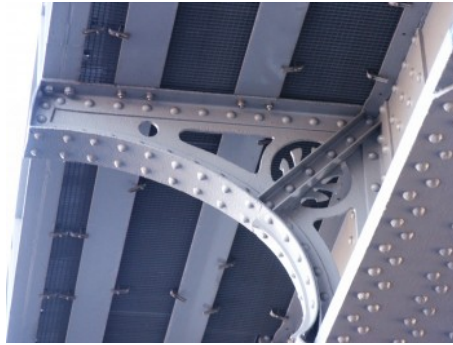
Viaduc du midi, console (photo 2004).
