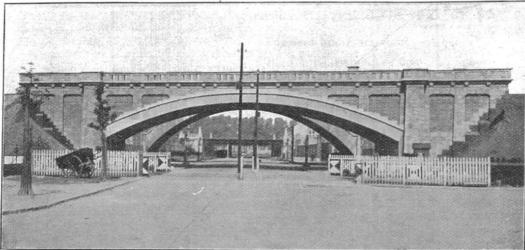
Photo 15. — Ligne de Bruxelles (Midi) à Mons. Pont de la rue du Charroi, à Forest.
