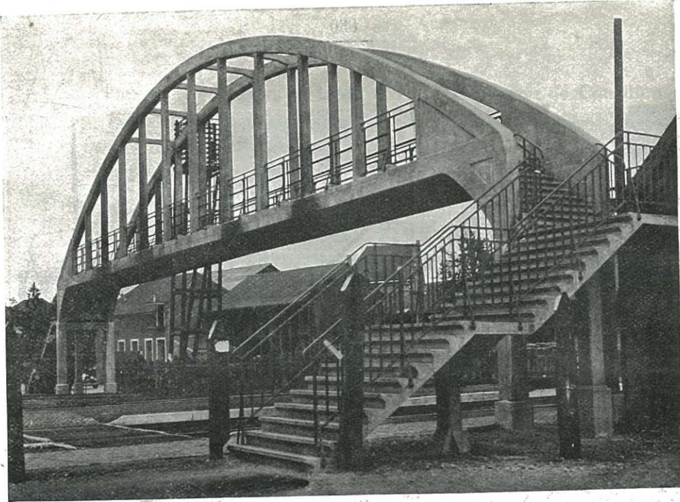
Photo 11. — Passerelle en gare d'Athus.
