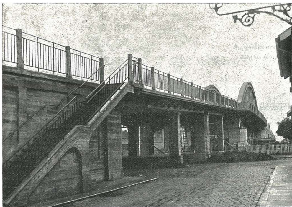
Photo 9. — Station d'Ath. — Suppression du passage à niveau.
