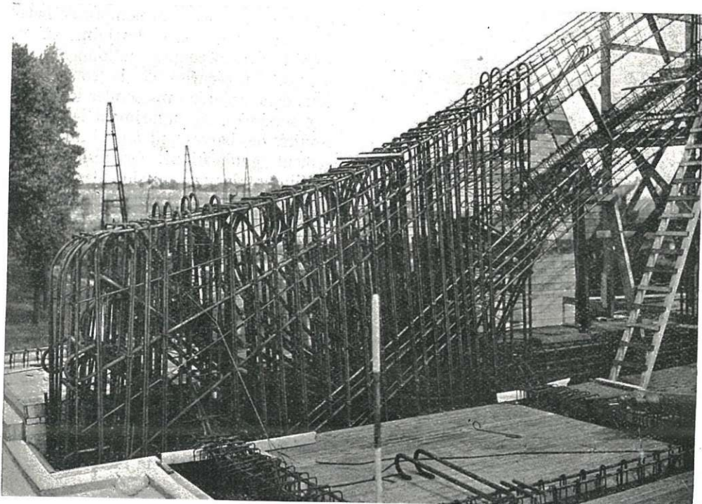
Photo 4. — Pont de Termonde. — Ferrailage d'une culasse d'extrémité.
