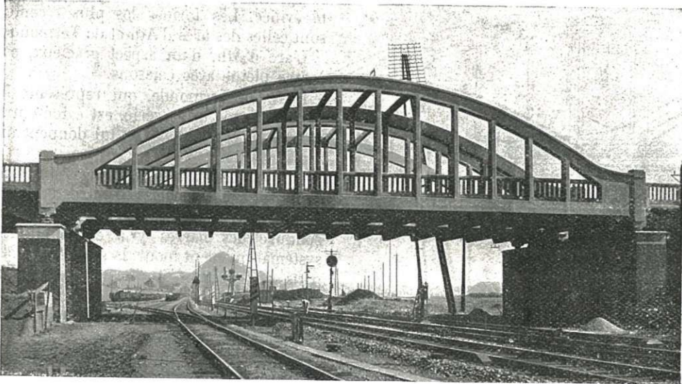
Photo 3. — Passage supérieur du « Gouffre ». Station de Châtelineau.
