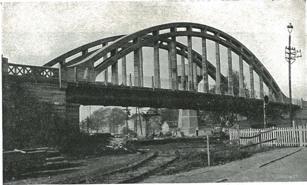
Photo 6. — Passage supérieur de Termonde. — Suppression du passage à niveau.
