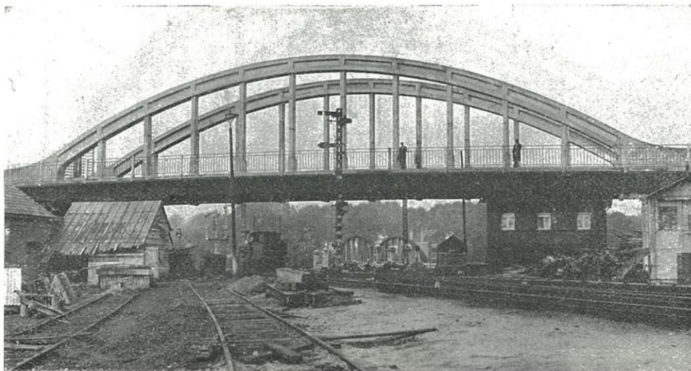
Photo 5. — Passage supérieur à Ath. — Suppression du passage à niveau.
