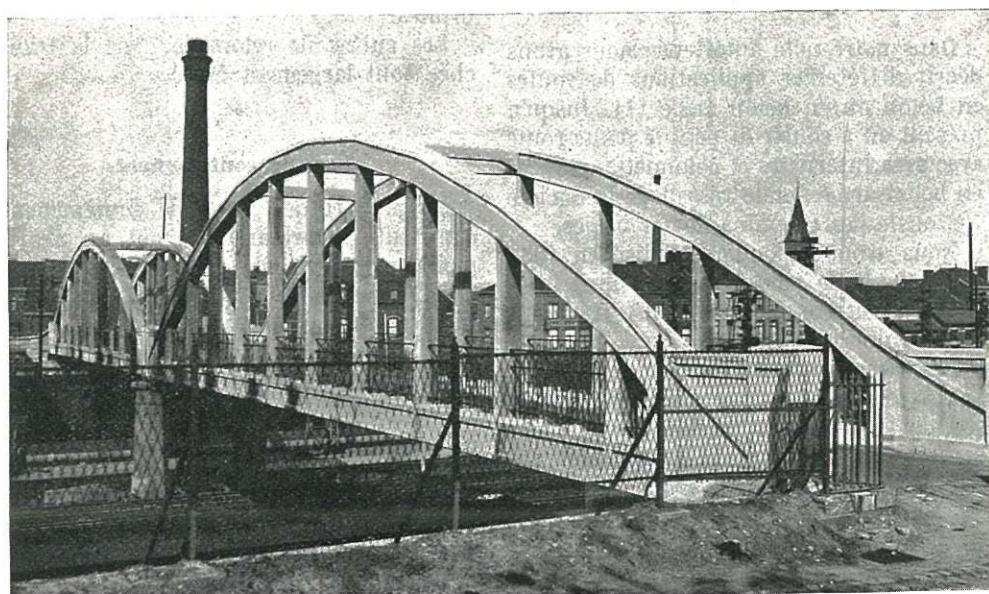
Photo 10. — Passerelle au-dessus de la gare de Liège-Guillemins.
