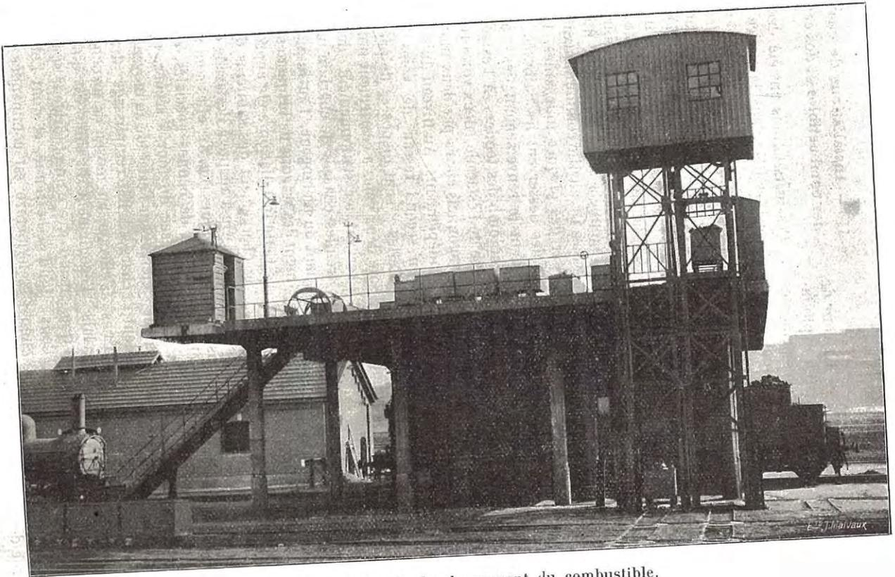
Fig 7. — Estacade de chargement du combustible.
