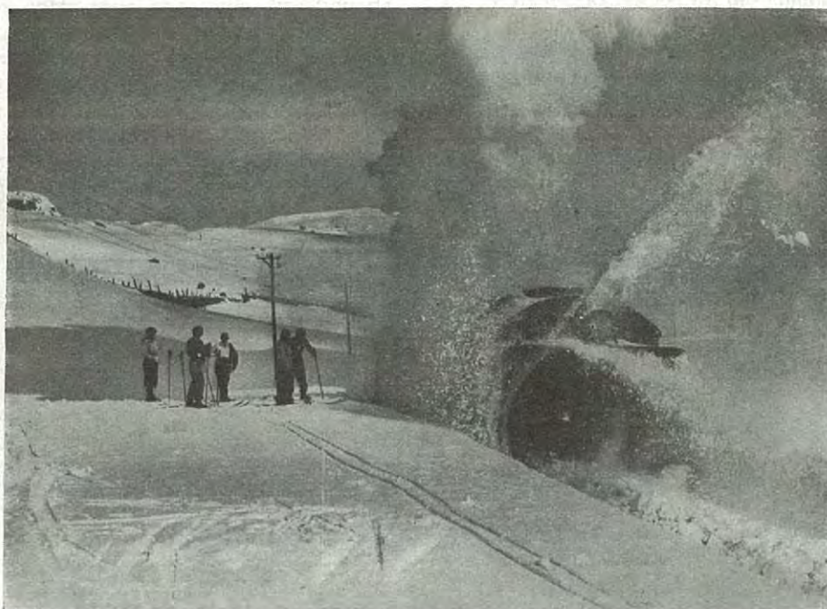
Fig. 307. — La lutte contre la neige au Chemin de fer de Bergen. Chasse-neige rotatif.
