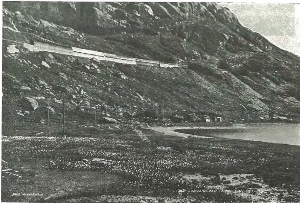
Fig. 309. — Galerie paraneige du Chemin de fer de Bergen.
