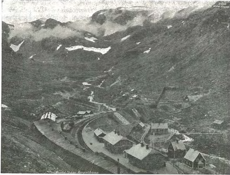
Fig. 310. — Entrée du tunnel de Gravaehalsen, à Myrdal. — Chemin de fer de Bergen.
