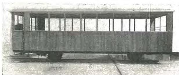
Fig. 239. — Voiture récente du Ch. de fer de Gornergrat, construite par les Ateliers de Schlieren.
