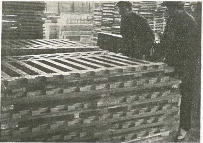
Fig. 10. — Panneaux de clôture sur aire de premier durcissement.
