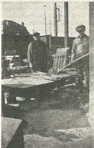
Fig. 12. — Table vibrante en action.
