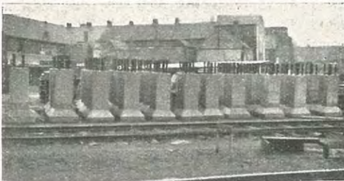
Fig. 5. — Fondations de sémaphores.
