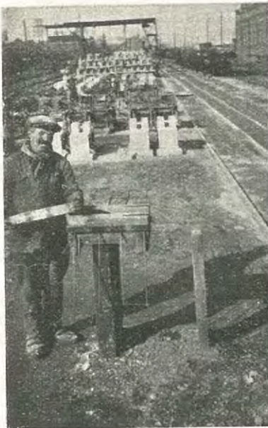
Fig. 17. — Carcan pour pliage d'armatures.
