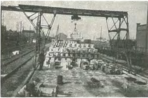
Fig. 22. — Manutention de pièces lourdes au moyen d'un portique muni d'un palan électrique.
