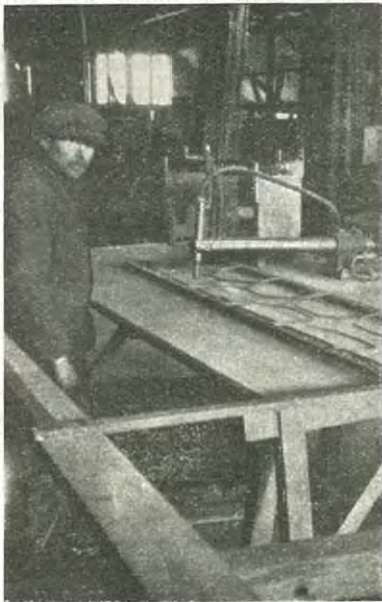
Fig. 16. — Soudure d'armatures.
