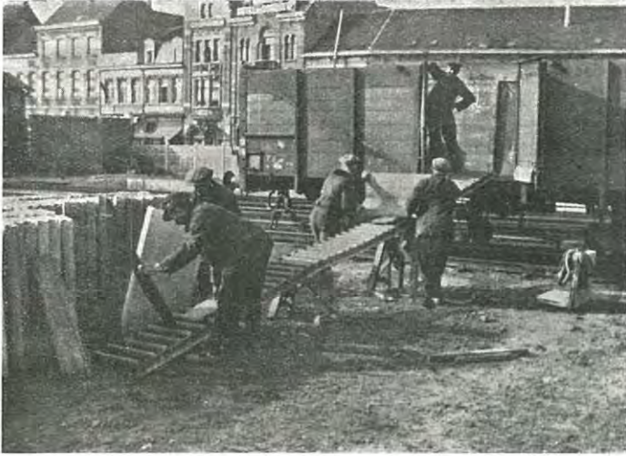
Fig. 21. — Chargement sur transporteurs à rouleaux.
