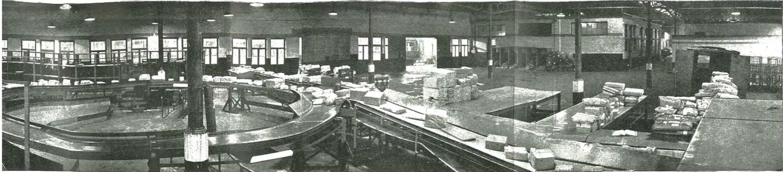
Fig. 7. — 1°) Vue panoramique de l'installation. colis sont déchargés sur les transporteurs de droite et sont repris devant les casiers sur les transporteurs de gauche.
