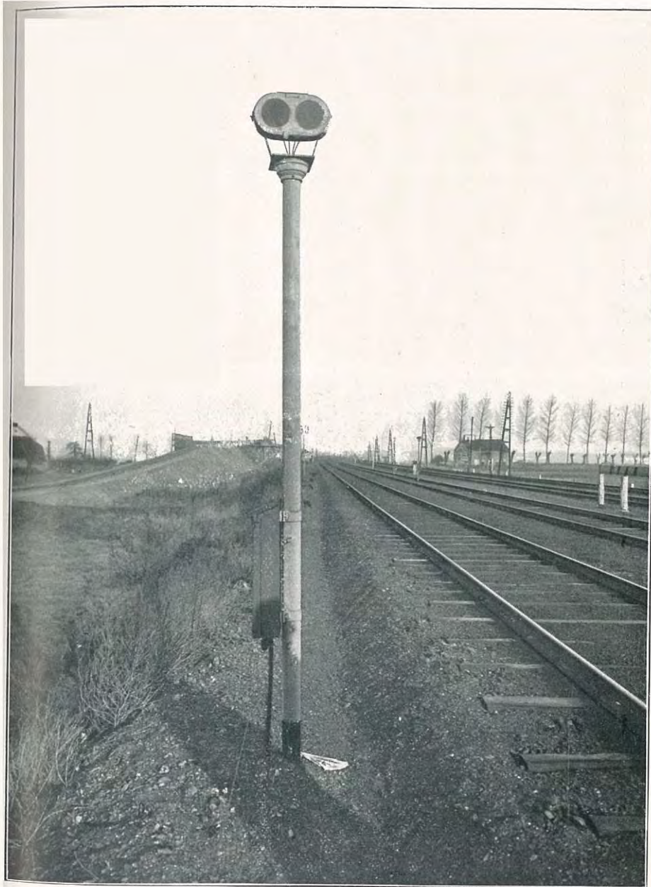
Fig. 38. — Répétiteur lumineux vu de face.
