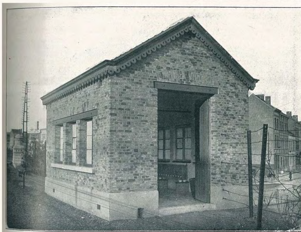
Fig. 53. — Vue du local abritant les accumulateurs.
