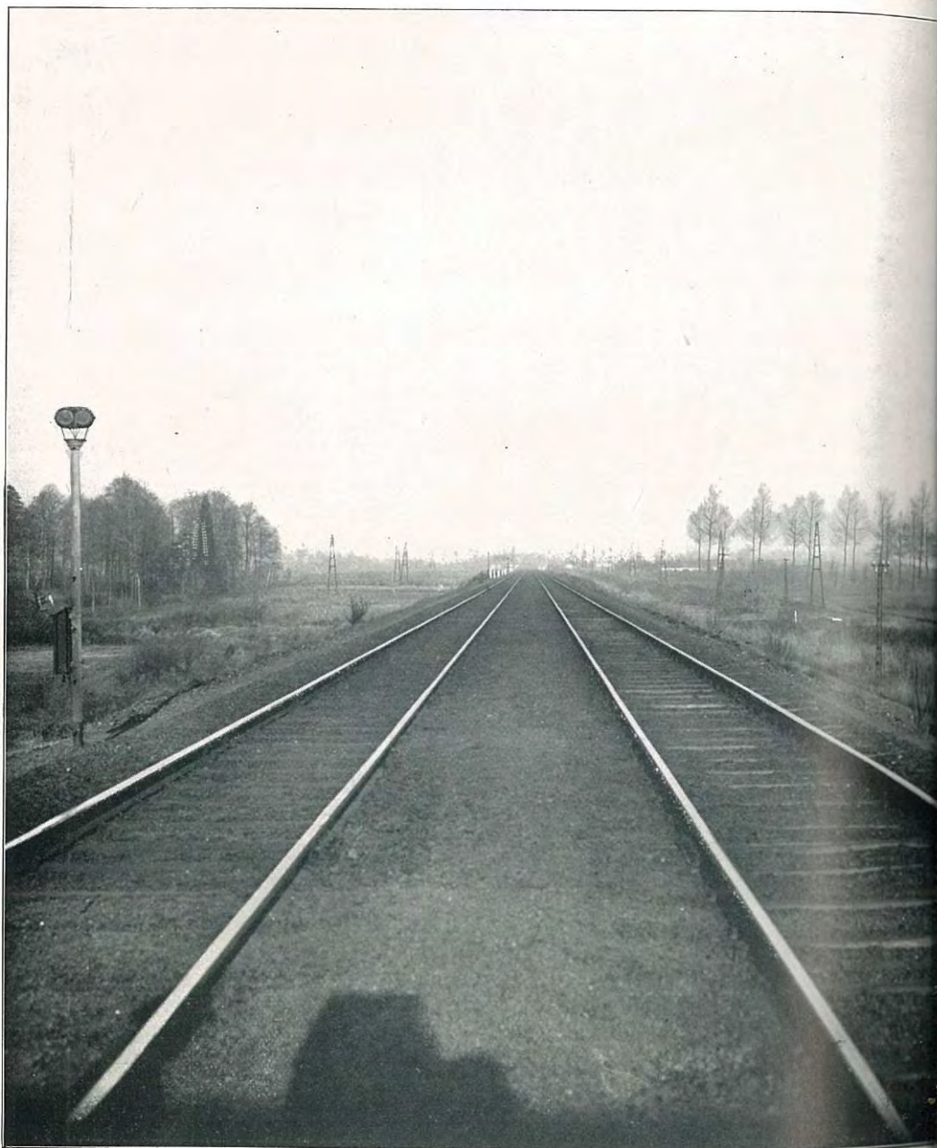
Fig. 37. — Vue d'un signal avertisseur muni des indicateurs optiques d'approche et des répéteurs lumineux.
