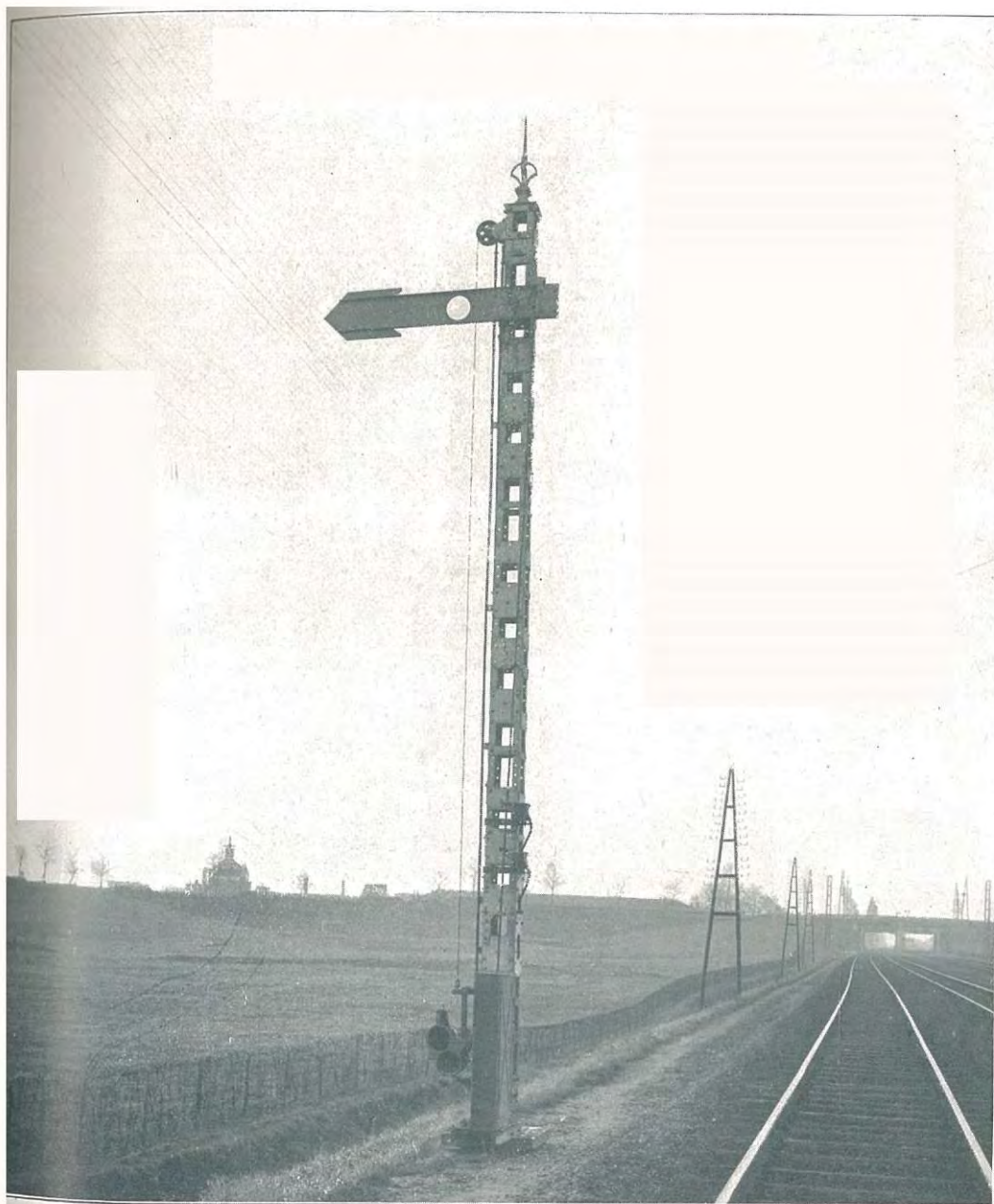
Fig. 14. — Vue d'un sémaphore muni d'une palette avertisseur.
