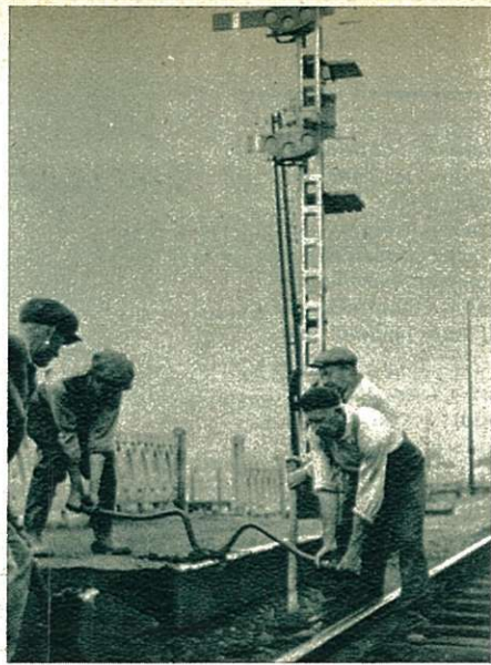
... une équipe enlève les obstacles pour laisser le champ libre à la « dégarnisseuse-cribleuse ».
