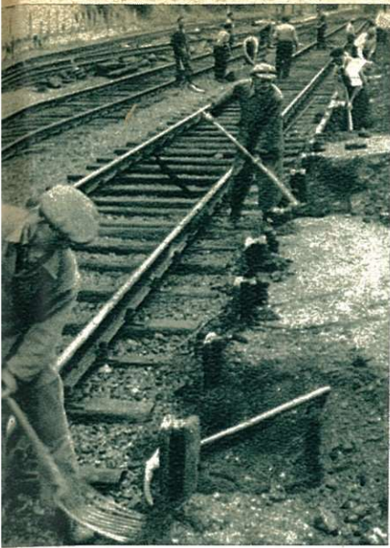
... une équipe enlève les obstacles pour laisser le champ libre à la « dégarnisseuse-cribleuse ».
