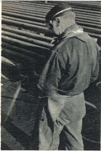
Chantier du rail — Meulage des extrémités des rails avant le soudage.
