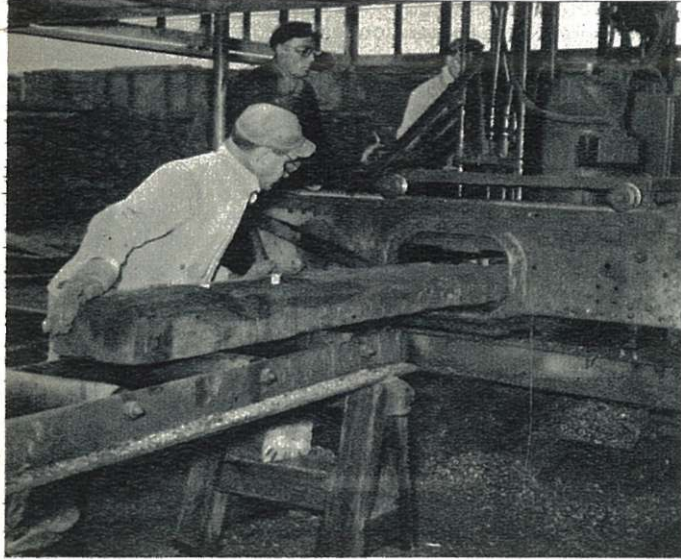
Chantier des traverses — Remaniage des traverses à l'entailleuse-perceuse
