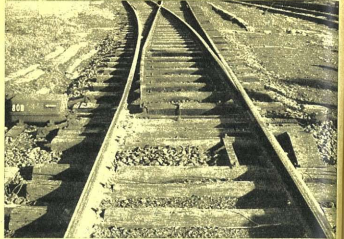
BRANCHEMENT DE VOIE AVEC AIGUILLES ARTICULEES. A GAUCHE, LE MOTEUR.
