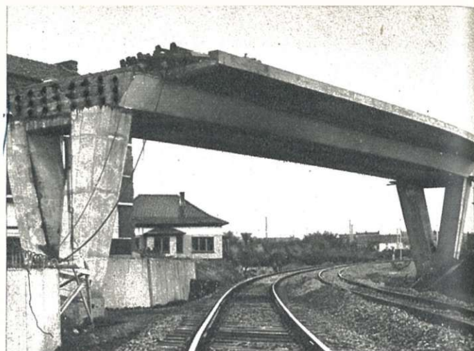
Vue d'un tablier de 26,50 m de portée sur ses appuis après décoffrage. Notez les têtes d'ancrage des câbles.
