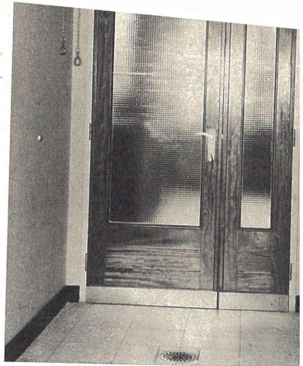
Une des portes de sortie d'un laboratoire de chimie équipée d'une douche de sécurité.
