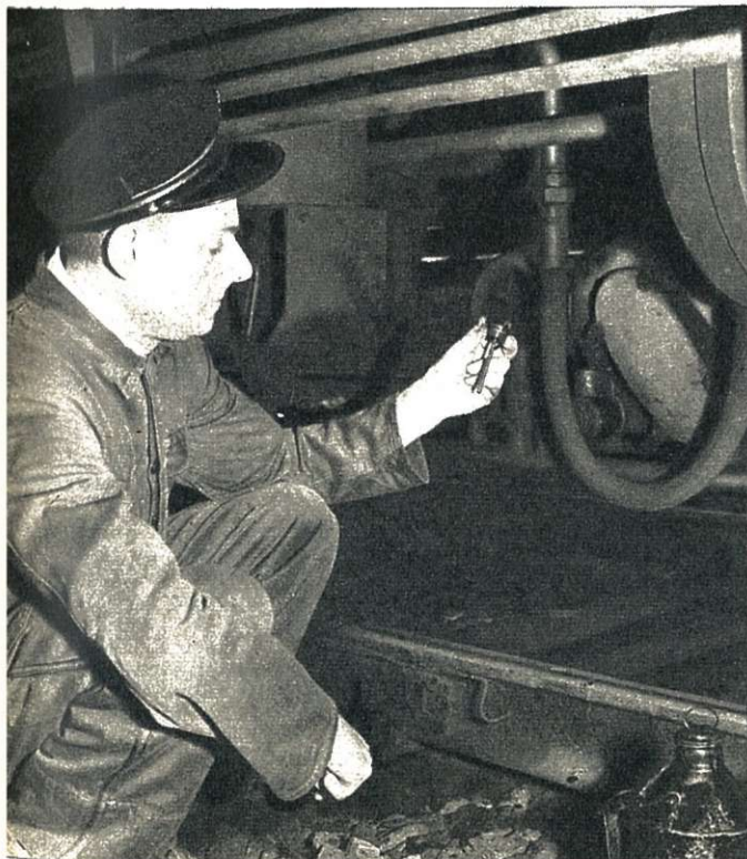
LA VÉRIFICATION DU NIVEAU D'HUILE DU COMPRESSEUR.
