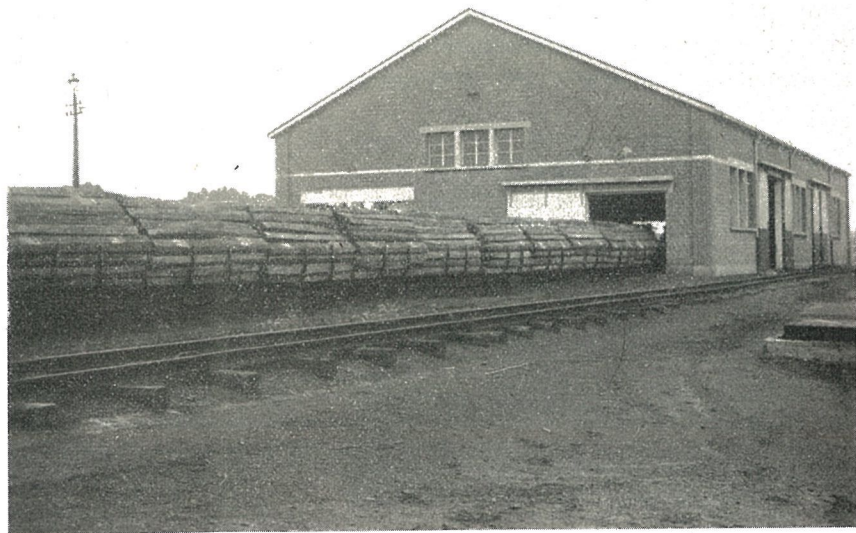
Rame de wagonnets de créosotage roulant depuis les machines à saboter jusqu'aux cylindres de créosotage
