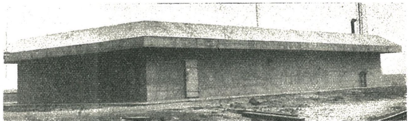
Une cellule sanitaire du chemin de fer
