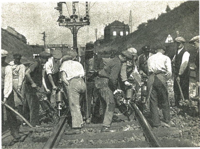
Bourrage à la machine. La canne à boule sert à vérifier la fermeté du bourrage.
