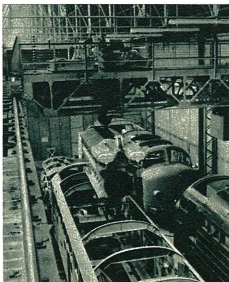
Dépose du groupe diesel-générateur dans la loco type 202.
