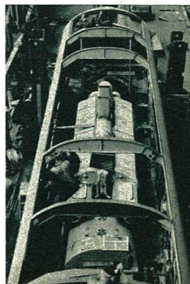
La salle des machines de la loco type 202.
