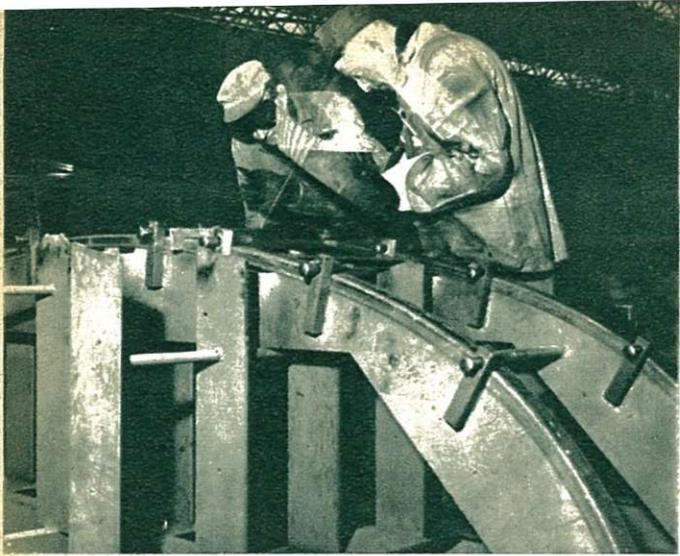
Un gabarit pour l'assemblage des éléments de la toiture.
