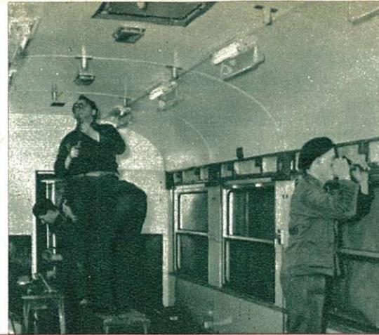
Pose du revêtement intérieur, essai de l'allumage et montage des ventilateurs.
