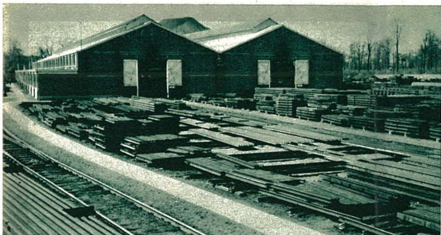
VUE EXTERIEURE DE L'ATELIER DE MONTAGE.
