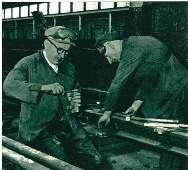
MONTAGE D'UN APPAREIL DE VOIE.
