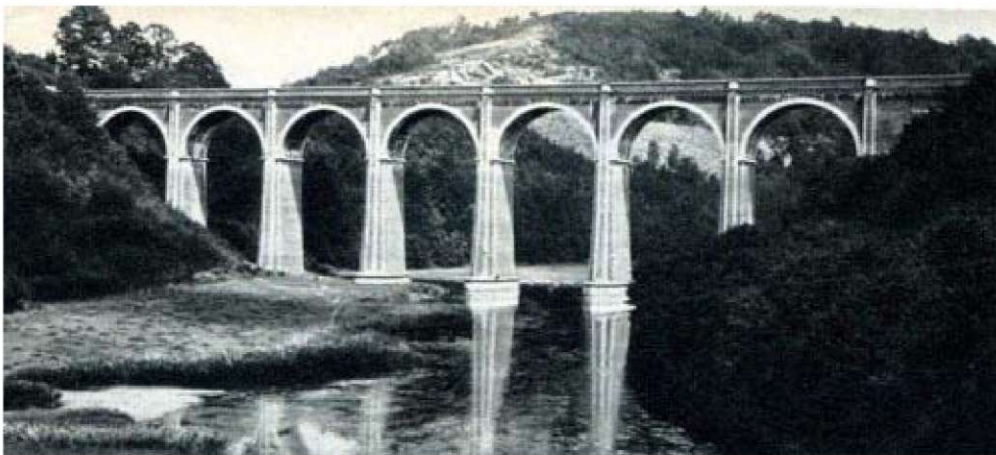
VIADUC D'HERBEUMONT franchissant la vallée de la Semois. Voûte en maçonnerie de briques de 18 m. d'ouverture.
