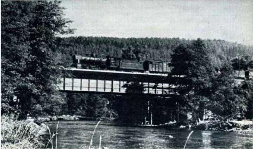
PONT SUR L'AMBLEVE A TARGNON Construction mixte acier-béton de 44 m. de portée.
