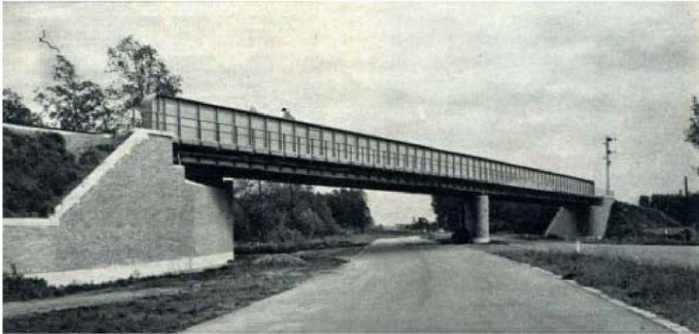
PONT SUR LAUTOROUTE BREENDONK – SAINT-NICOLAS A BORNEM Deux ouvertures de 46 m. Poutres principales à âme pleine en garde-corps.
