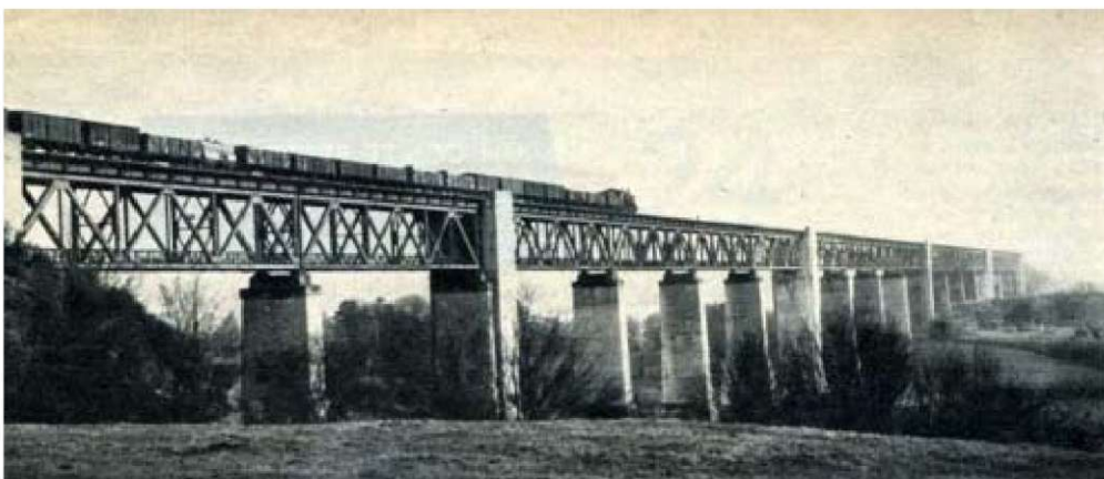
VIADUC DE MONTZEN Le plus long ouvrage d'art du réseau. Longueur totale : 1.107 m. Vingt-deux travées de 48 m. de portée. Poutres principales en treillis sous voies.
