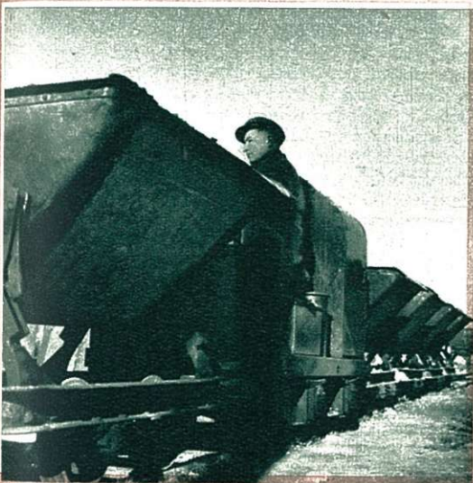
Het smalspoortreintje, geladen met verse beton.
