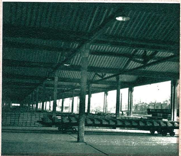
De gestapelde betonstukken.
