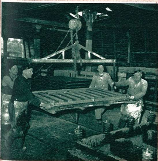
Een vorm wordt naar een triltafel (op voorplan rechts) gebracht.
