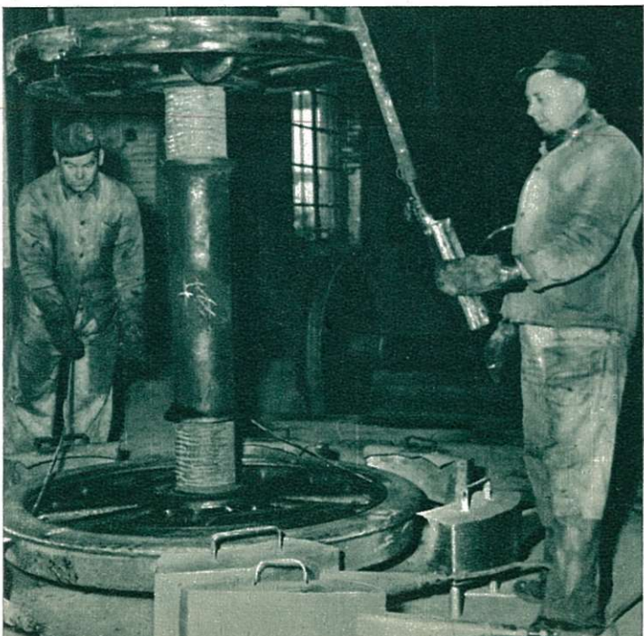
Het herplaatsen van de wielbanden.
