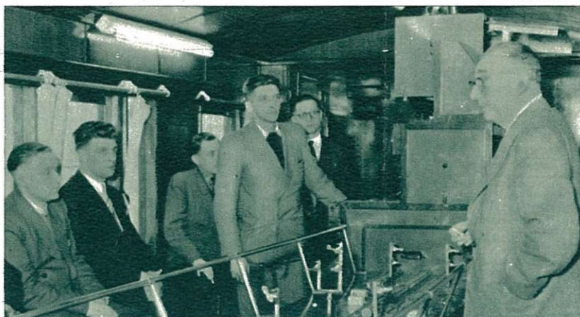
Bediening van een elektrisch seinhuis (normaal type).
