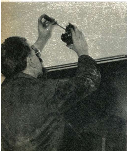
en het plaatsen van een thermostaat.
