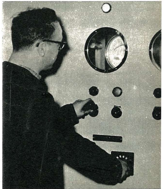
Controle van de elektrische uitrusting, in een werkplaats.
