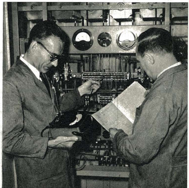
Een meestergast en een hoofdelektromechaniciërs verrichten metingen aan de apparatuur van een 48 V-gelijkrichter.
