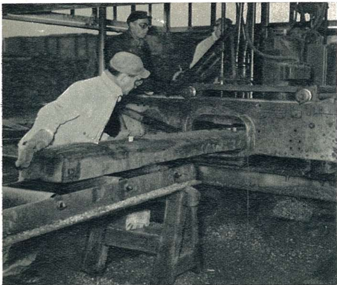
Werk der dwarsliggers — Herstellen van dwarsliggers met de inkepmachine.
