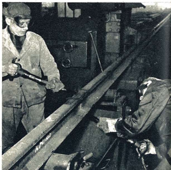
Onder profiel brengen der gelaste voeg door middel van pneumatische beitel.
