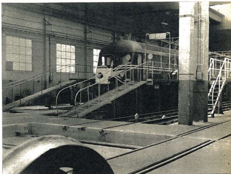
De loopbruggen van de dieselwerkplaats vergemakkelijken de verplaatsingen van de bedienden en de behandeling van de zware stukken.
