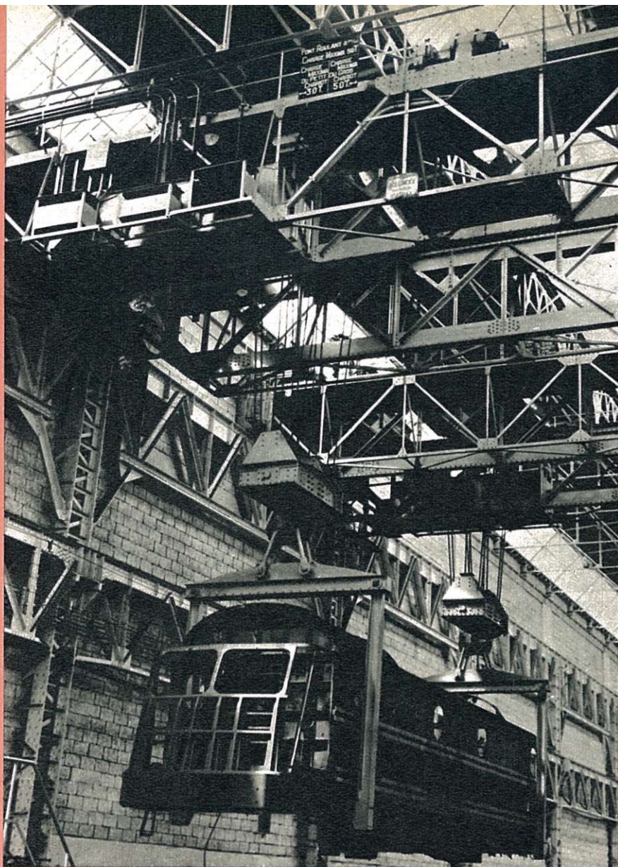
Gebruik van twee bruggen van 50 ton voor het lichten van een kast.
