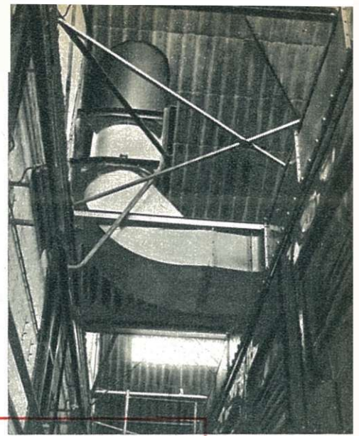
L'air pollué quitte le chantier par cette gaine d'évacuation d'air grâce à un puissant aspirateur.
