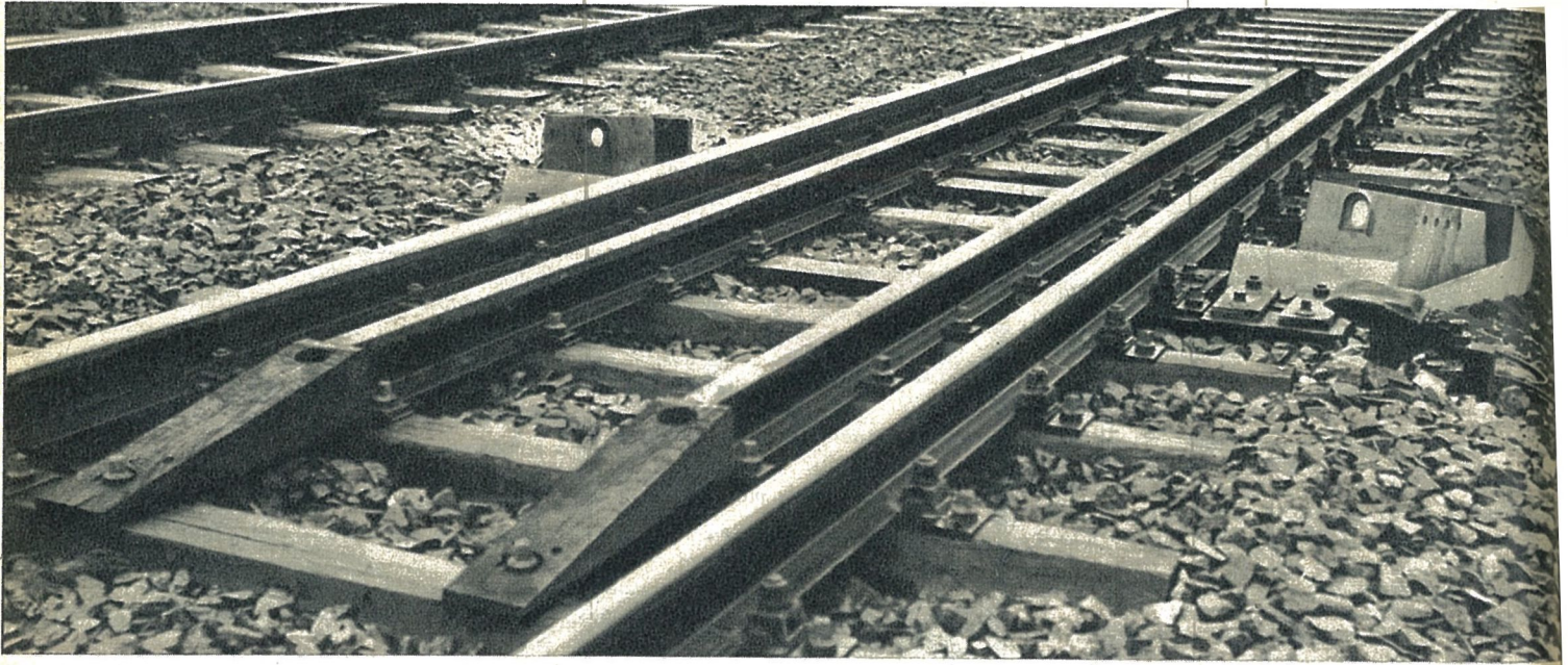
Photo 1 : les lecteurs qui détectent les boîtes chauffantes.
