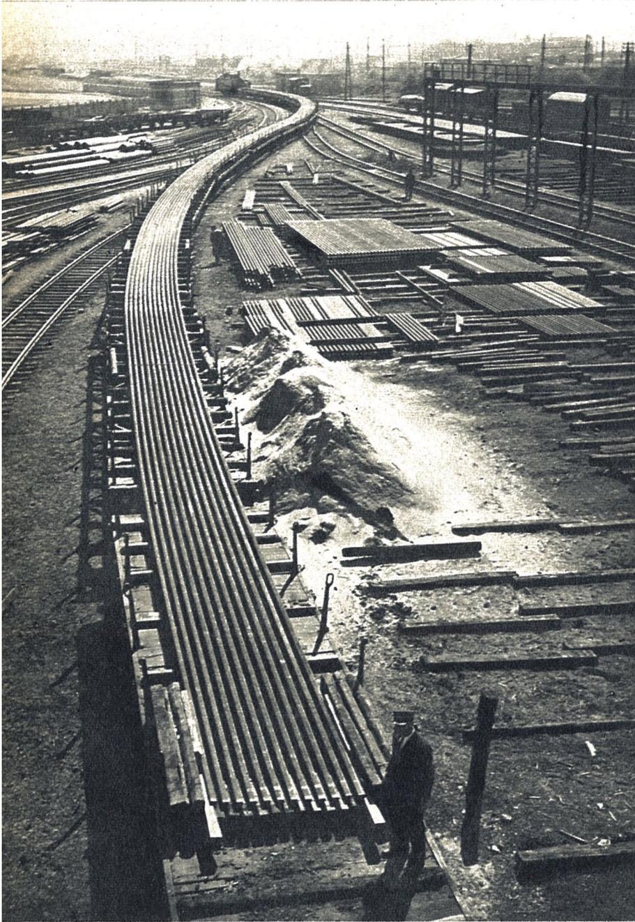
Pendant longtemps, l'industrie n'a pu fournir au chemin de fer que des rails courts (au début 4,57 m, pour finir par 27 m) et comme on ne connaissait pas le moyen adéquat de souder ces barres les unes aux autres, on les joignit le mieux qu'on put : on réunissait d'abord deux rails sur un même coussinet et bientôt on imagina des pièces d'assemblage, appelée « éclisses ».
