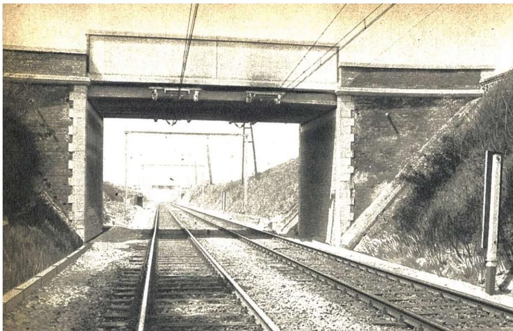
*Adaptation d'un passage supérieur pour la mise au gabarit électrique ; remplacement de la voûte par un tablier plat (entre Fontaine-Valmont et Labuissière).*
