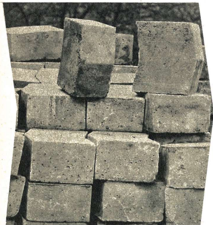
LES VOUSSOIRS DE BETON PREFABRIQUES. A REMARQUER LA FORME EN CHEVRON, QUI ASSURE LA SOLIDARITE ENTRE LES ANNEAUX.
