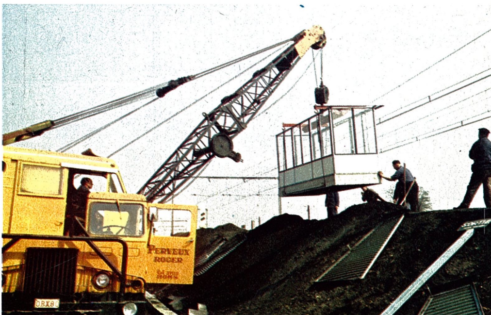
Photo 4 : Pose d'un abri au moyen d'une grue.
