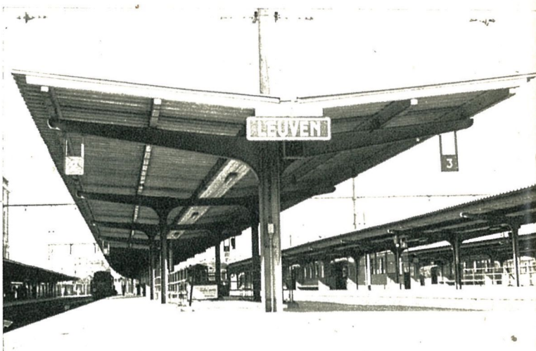
Photo 9 : Type amélioré d'abri-parapluie avec portiques en T, combinaison de parties soudées et de parties boulonnées. Pannes légères. Toit visible en plaques ondulées d'asbeste-ciment.
