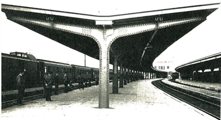
Photo 8 : Ancien type d'abri-parapluie. Portiques en forme de T à rivets visibles, hauts longerons en treillis. Chevrons et voliges en bois visibles. Couverture en zinc.
