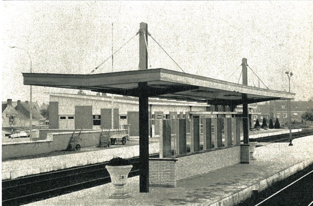
Photo 11 : Abri-parapluie très élégant. Les tirants entourant la tête des poteaux permettent d'augmenter la distance entre les portiques et d'agrandir la portée du porte-à-faux sans devoir alourdir les longerons.
