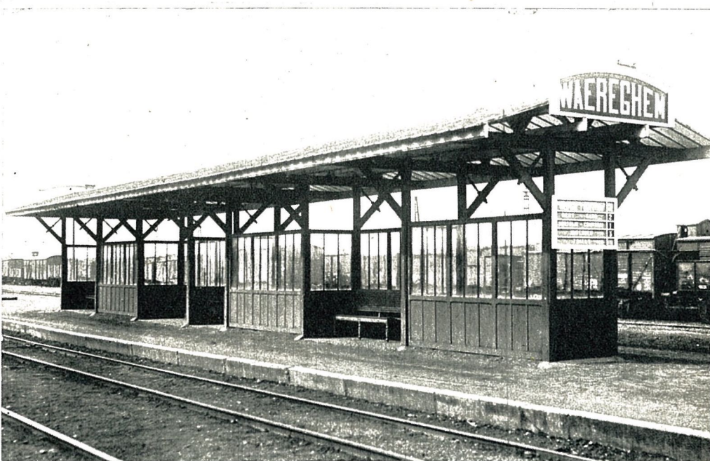
Photo 5 : Abri à charpente en bois, avec coupe-vent. A été remplacé depuis quelques années par un abri-parapluie.
