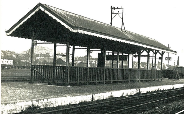
Photo 6 : Couverture d'escalier de couloir sous voie. Ossature en bois et toit incliné recouvert d'ardoises.
