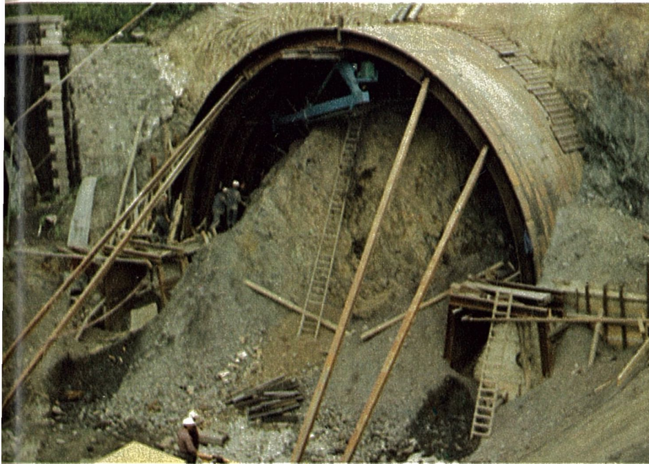
Photo 4 : tête vers Namur. Vue extérieure des tôles de blindage « liner-plate ». Les palplanches horizontales sont posées, elles commencent leur progression dans le terrain. En clef, appareil de manutention des cintres.
