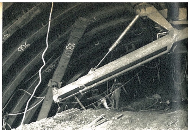
Photo 7 : front d'attaque. Pose d'un cintre.
