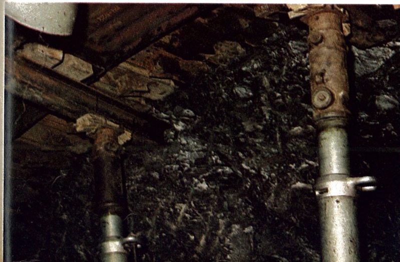
Photo 4 : tête vers Namur. Vue extérieure des tôles de blindage « liner-plate ». Les palplanches horizontales sont posées, elles commencent leur progression dans le terrain. En clef, appareil de manutention des cintres.
