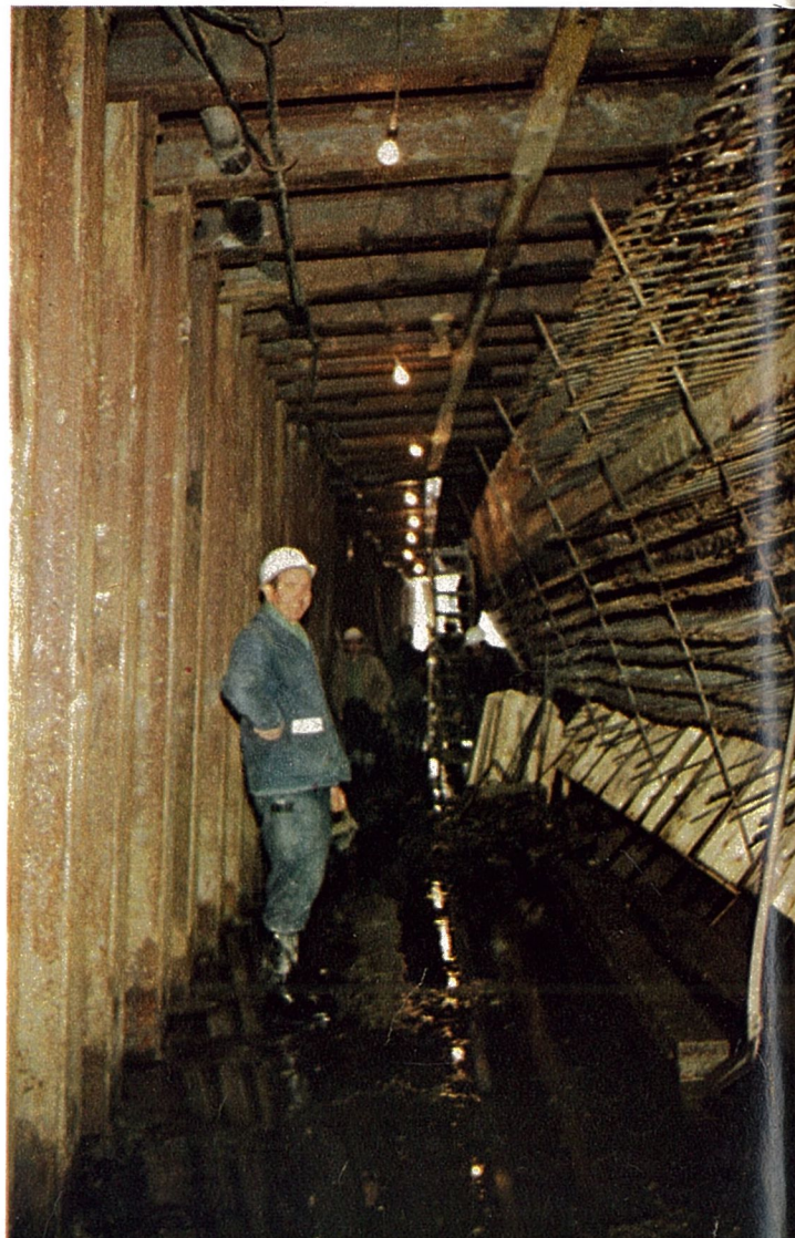
Photo 1 : tête vers Namur - débouché des galeries. A remarquer les tuyaux d'aération du front d'attaque et la boue sortant des galeries.
