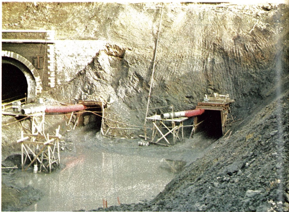
Photo 1 : tête vers Namur - débouché des galeries. A remarquer les tuyaux d'aération du front d'attaque et la boue sortant des galeries.
