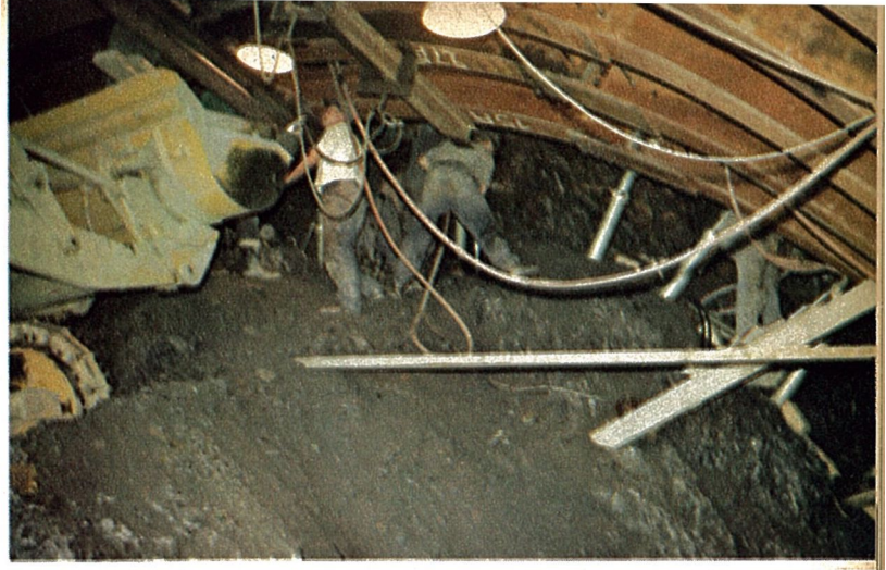
Photo 6 : front d'attaque. Cintres et stross central.
