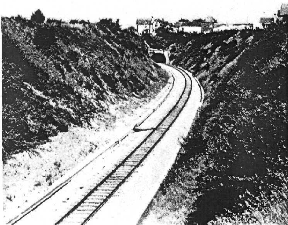
La ligne de Philippeville à Saint-Lambert avait été abandonnée et démontée en 1954. On aperçoit l'entrée du tunnel complètement restauré de Philippeville, qui passe sous un pâté de maisons de cette localité. Au premier plan, la tranchée était devenue un véritable étang, où vivaient poules d'eau et rats musqués. La plateforme asséchée et les voies nouvellement posées attendent le premier train.
