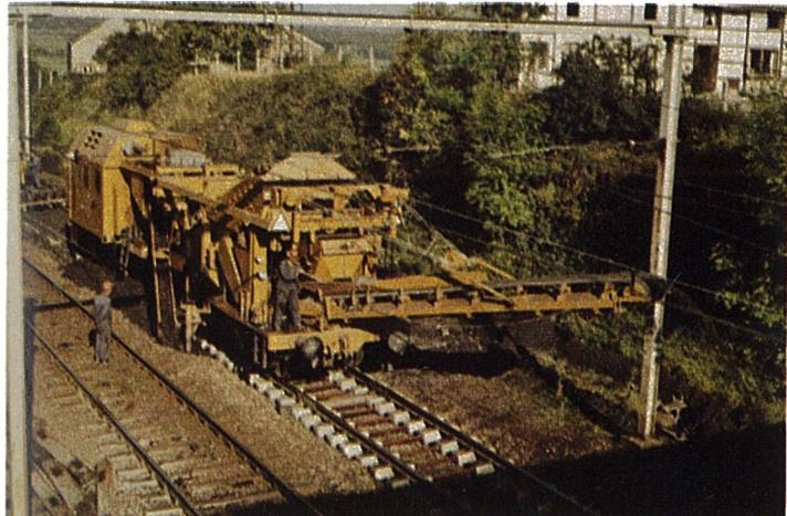
Des opérations de renouvellement des voies, le criblage du ballast était la plus pénible. Depuis quinze ans environ, ce travail est réalisé en majeure partie par des dégarnisseuses-cribleuses qui enlèvent le ballast sous les traverses, le criblent, remettent le ballast propre dans la voie et versent les détritus sur la piste.
