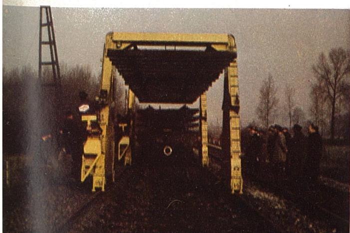
Mais l'image de la mécanisation des travaux de voie ne serait pas complète si nous ne parlions pas des autres opérations de renouvellement, à savoir le renouvellement des rails et des traverses. Les portiques représentés qui posent et déposent des travées entières de voie constituent un premier essai réalisé sur la ligne Louvain-Aarschot.
